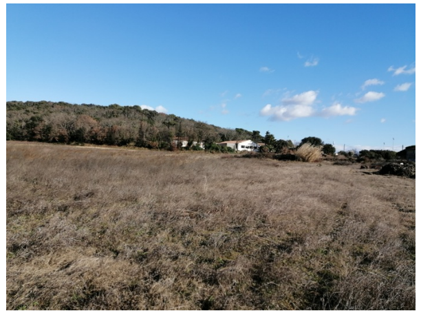
Zone du chantier avant le décapage
