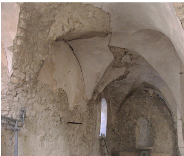
Photo 16 : Intérieur en cours de travaux
