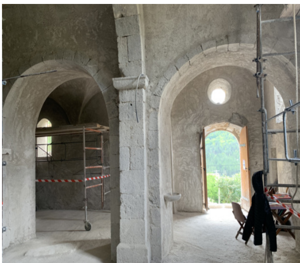
Photo 22 : Porte d'entrée en cours de travaux
