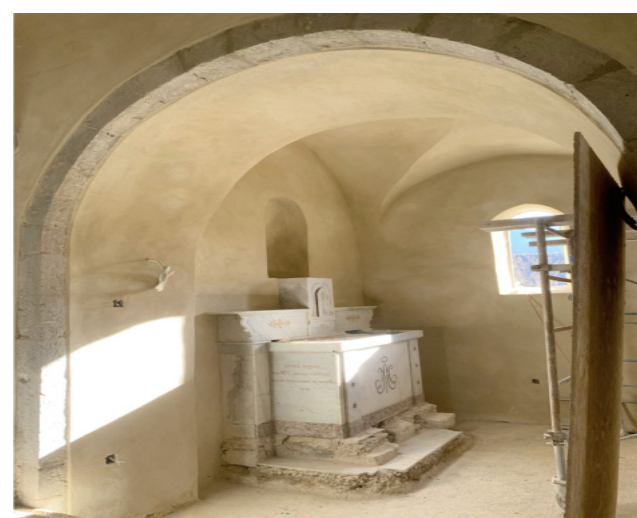
Photo 19 : Autel Vierge en cours de travaux
