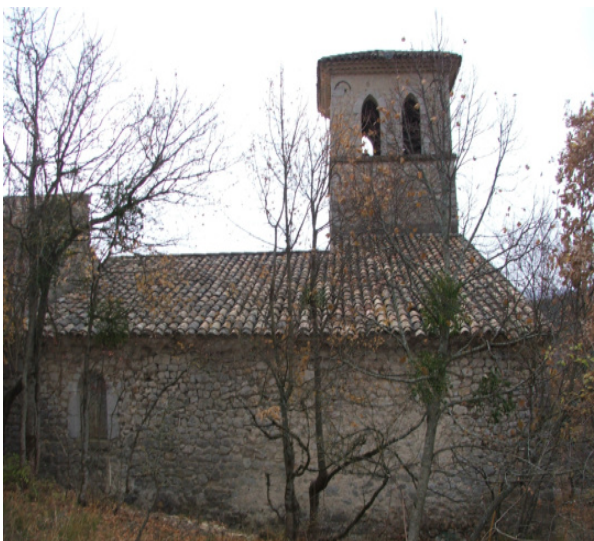
Photo 14 : Façade nord et toit avant
