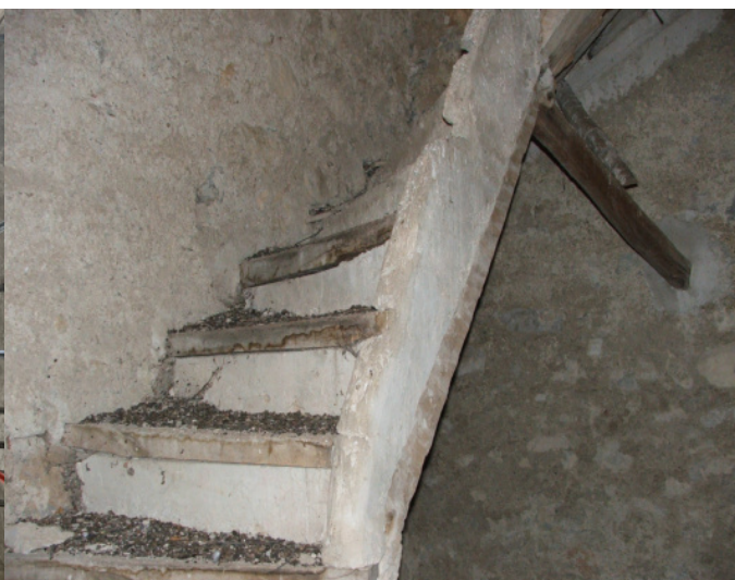
Photo 23 : Escalier d'accès au clocher avant
