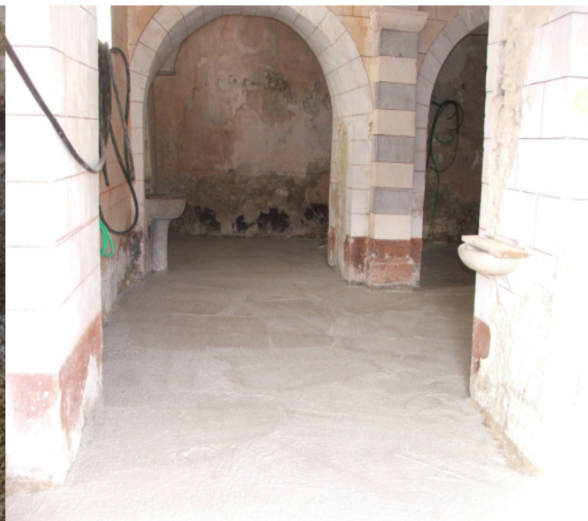
Photo 21 : Sol en cours de travaux
