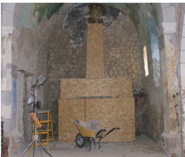
Photo 18 : Maitre Autel en cours de travaux
