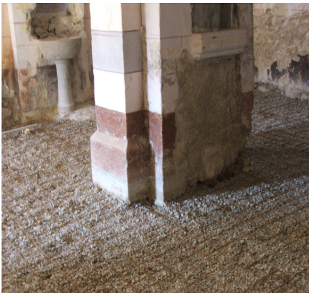
Photo 20 : Sol en cours de travaux
