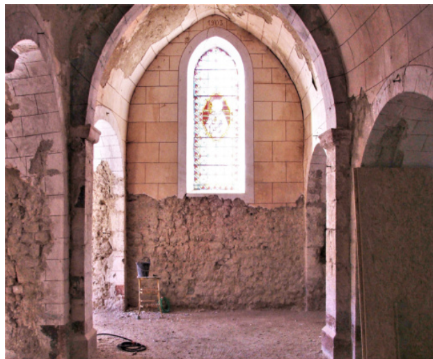
Photo 17 : Vitrail St-Clair en cours de travaux
