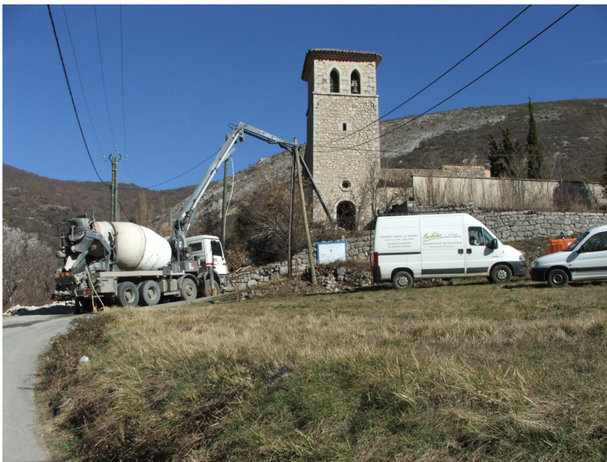
Photo 13 : Chantier vue générale
