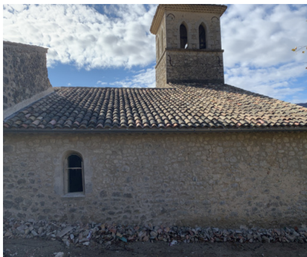
Photo 15 : Façade nord et toit après
