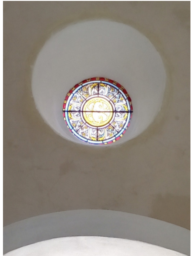
Photo 30 : Vitrail oculus de la façade sud (restauré)
